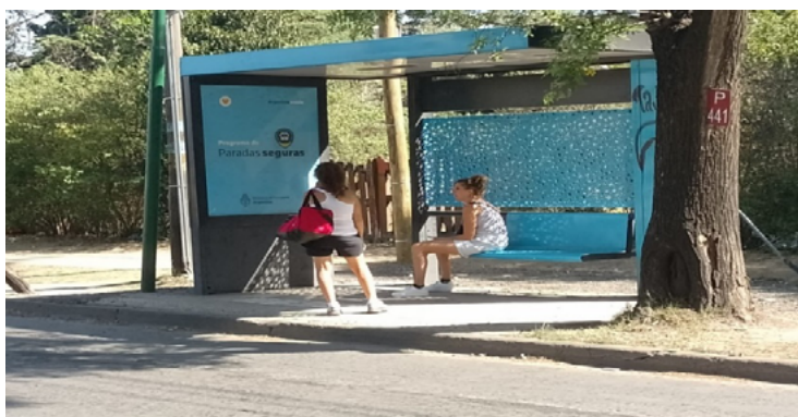
Figura 3. Parada segura en la localidad de Villa Udaondo, municipio de Ituzaingó.
